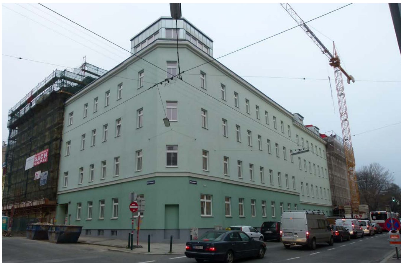
Abb. 3: Ensemble an der Ecke Davidgasse/Muhrengasse während der Bauphase (Quelle: Bluwaters)
