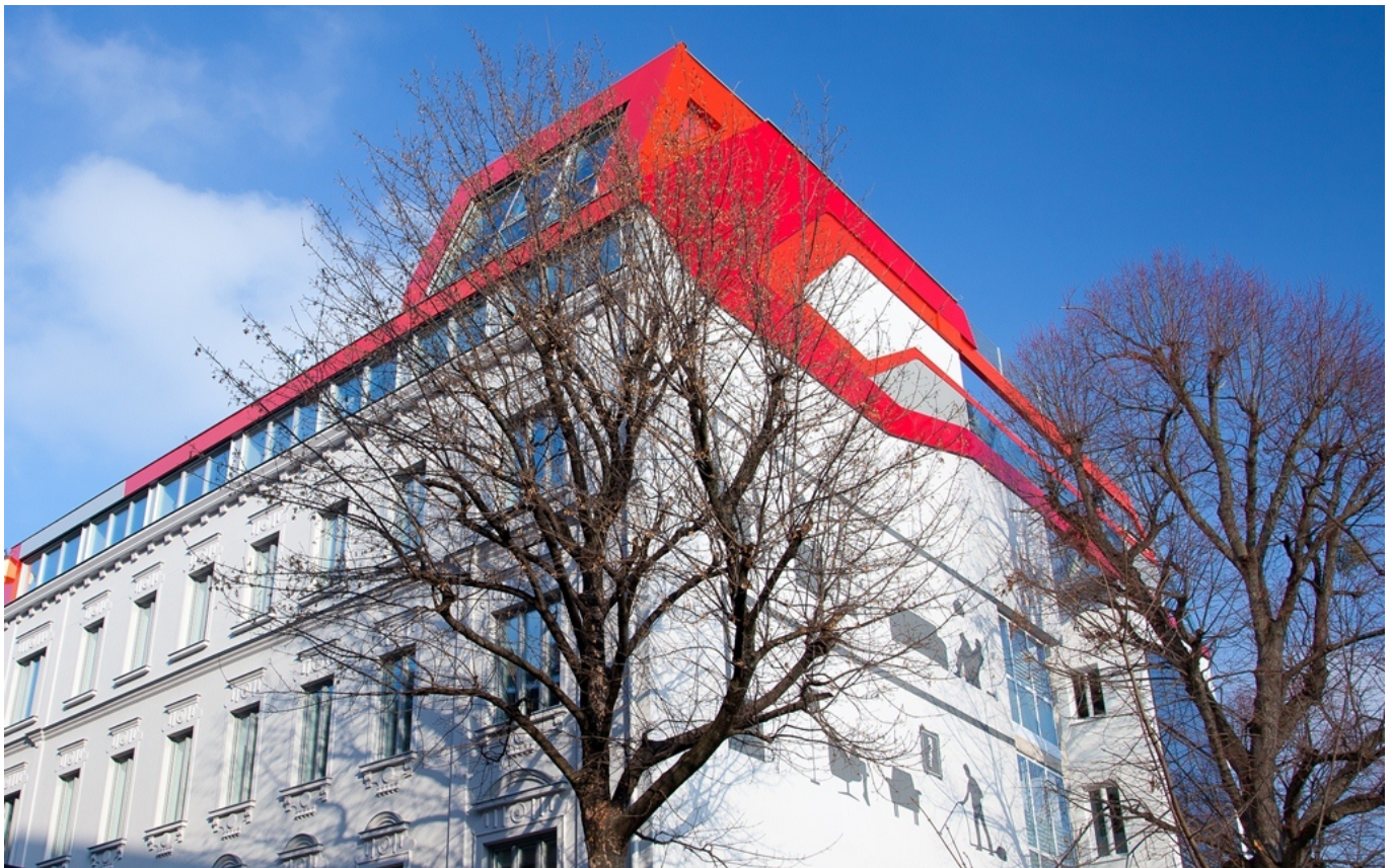
Abb. 4: Objekt Wißgrillgasse mit Dachgeschoßausbau nach Sanierung (Quelle: Ulreich Bauträger GmbH)
