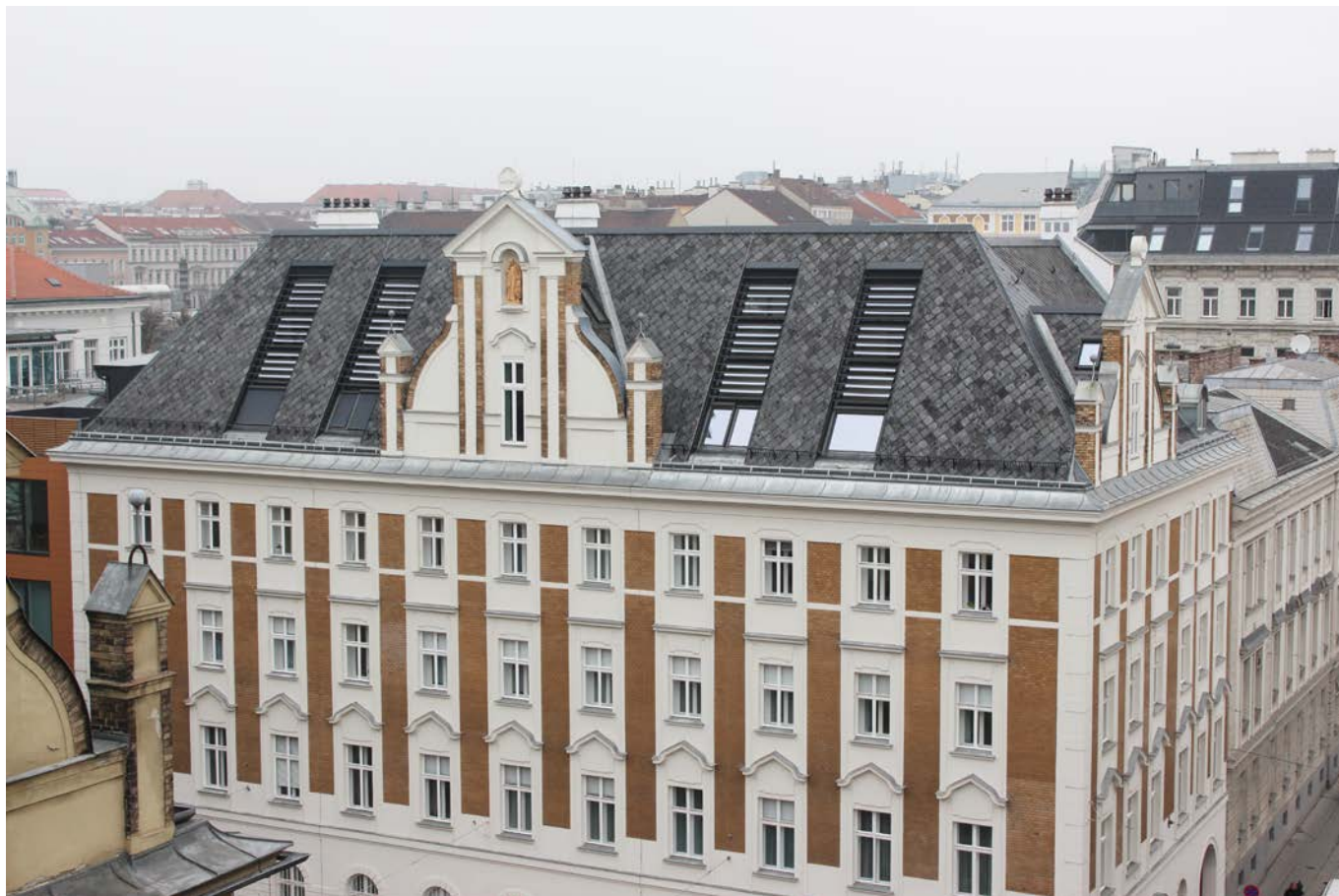
Abb. 1: Objekt Kaiserstraße nach Sanierung und Dachgeschoßausbau (Quelle: kronreif_trimmel & partner)
