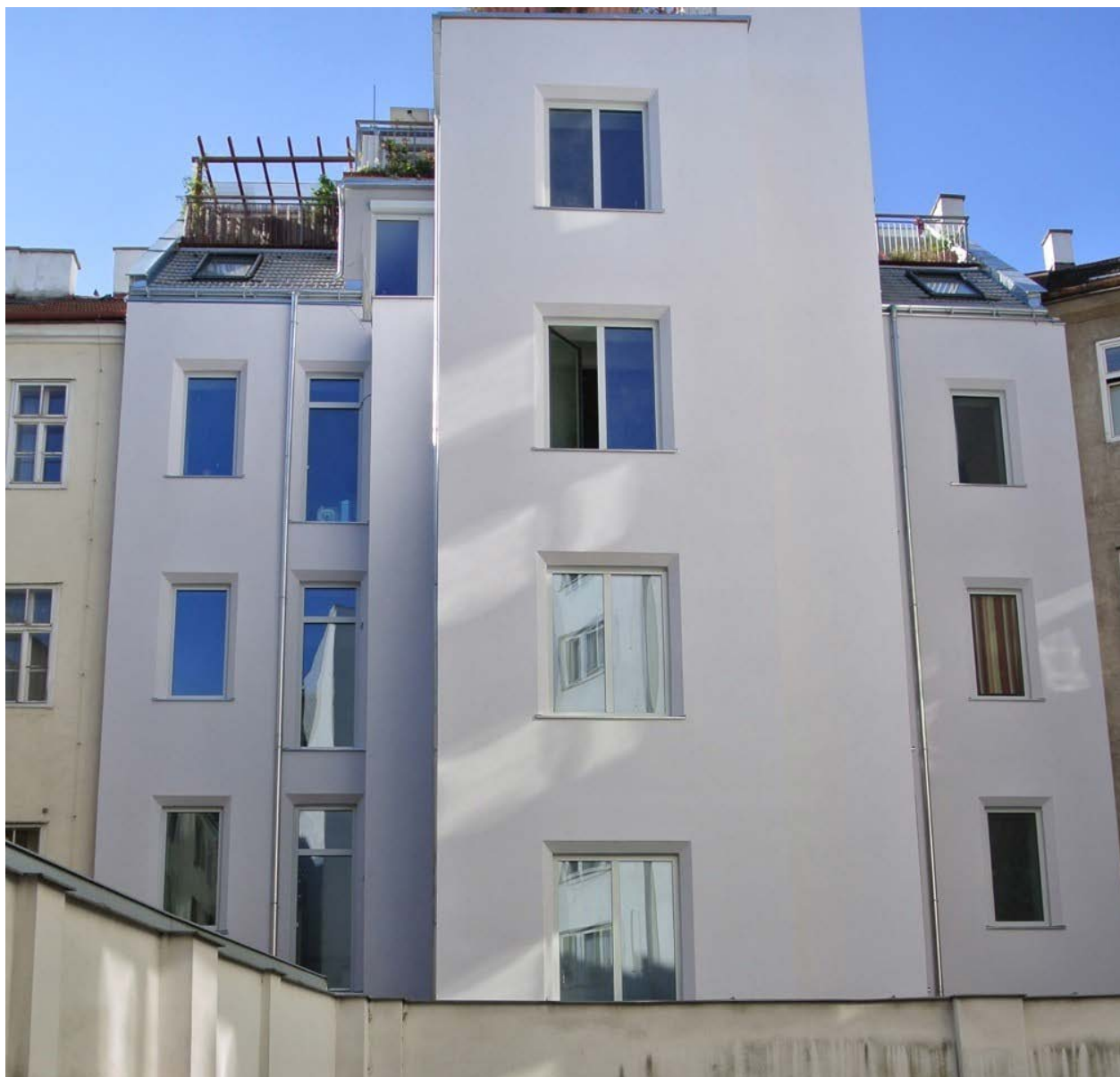
Abb. 2: Hofansicht des Objekts Eberlgasse nach Sanierung (Quelle: Kronberger)
