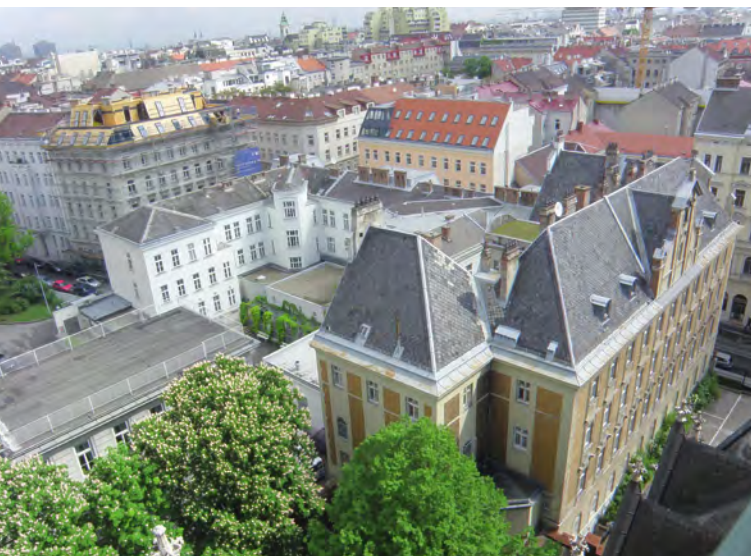
Kaiserstraße Wien, Quelle: Architekten Kronreif_Trimmel & Partner
